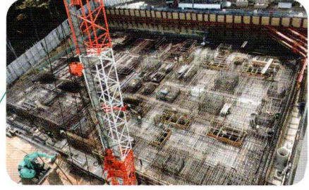
2019年10月 基礎工事
