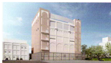
2021年7月竣工予定のBSL-4施設
